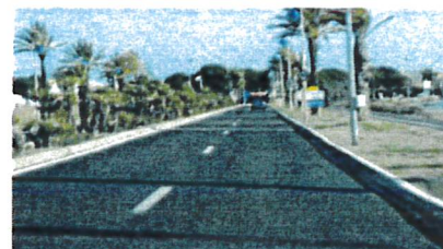
Entrée de ville dotée de plantations d'alignement Impact visuel de la bande lumineuse
