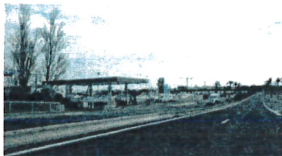
Impact du auvent de la station-service
